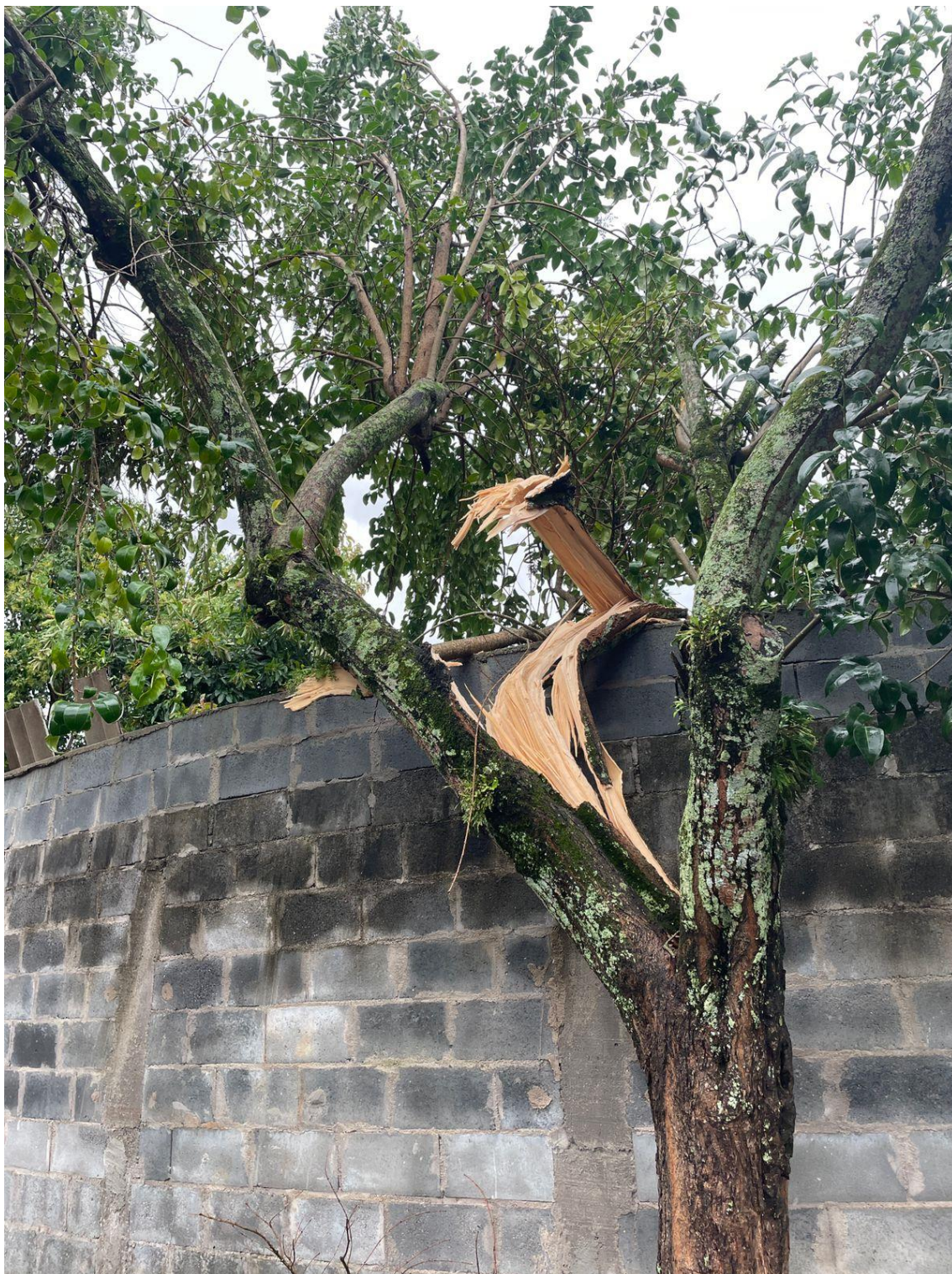
Figura 2. Árvore da rua, caída no muro do morador local.
